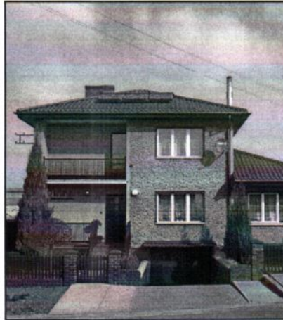
Na dachu swego domu Przemysław Tajchert ma zamontowany zestaw kolektorów słonecznych
